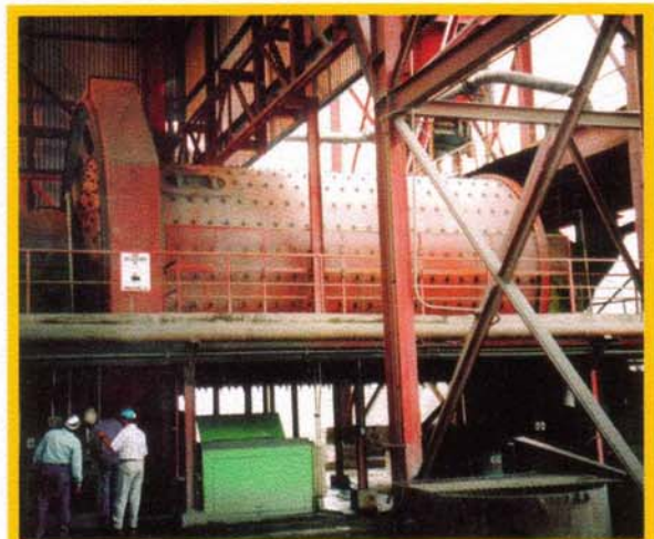
Kugelmühle für die Erzvermahlung Ball mill for ore milling
